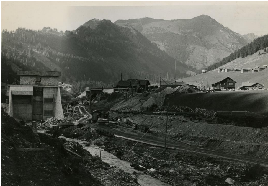
Bau des Auslaufwerks beim Staudamm des Saminakraftwerks im Steg, 1949.
