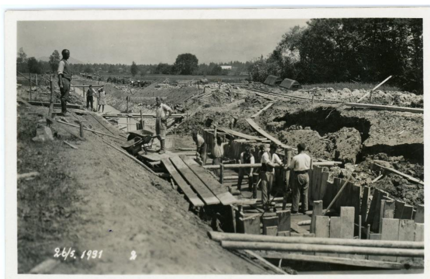
Binnenkanalbau. Arbeiten beim Parallelgraben in Ruggell, 1931.
