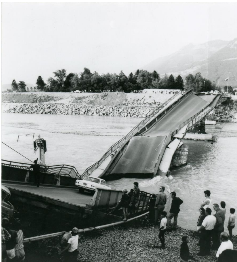
Der Rhein unterspült die Pfeiler der Strassenbrücke zwischen Schaan und Buchs. Die Brücke stürzte daraufhin am 14. August 1970 ein.
