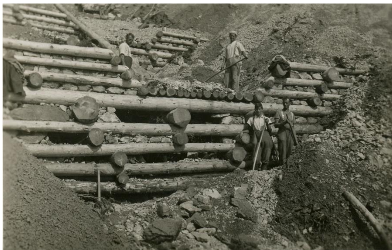
Bauarbeiten bei der Alpila-Krüppel-Rüfe, 1937.
