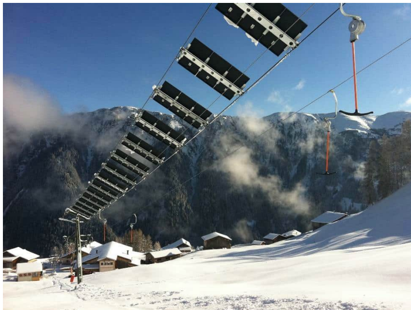
Solarlift Tenna, Quelle: www.graubuenden.ch
