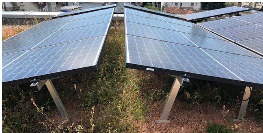
Flachdachsystem auf Dachbegrünung und breiten Gängen für Wartungsarbeiten
